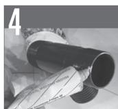
Para asegurar una buena unión entre piezas "T" y caños, se debe colocar sellador verde en los extremos de cada "T" y utilizar pistola de calor o agua caliente para ablandar y enchufar correctamente los extremos de cada caño.
