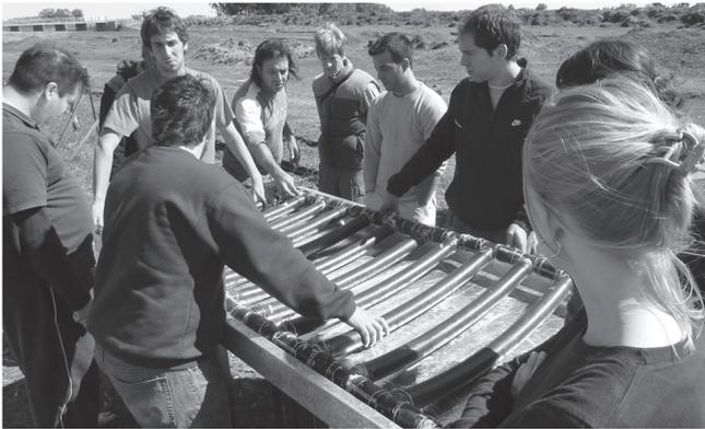
Construcción del colector solar.
