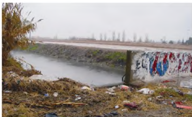
Figura 43 – Calle 19 y 520- Puente sobre el Arroyo del Gato
