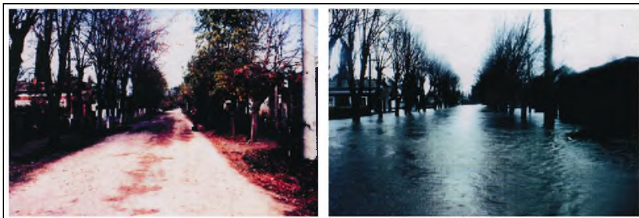
Fig. 41 - La misma calle, trazada sobre un antiguo cauce desviado, que se inunda ante una crecida.
