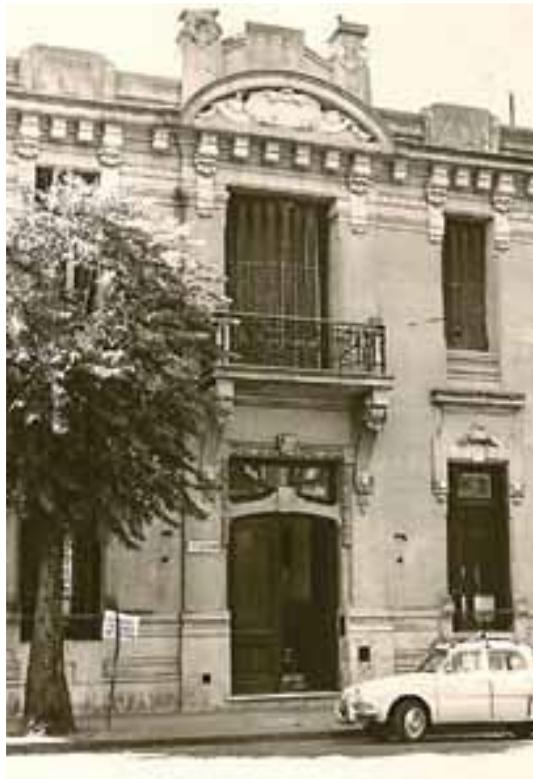
Figura 3. Edificio donde funcionara la Società Scuole Italiane de La Plata, fundada en marzo de 1896
