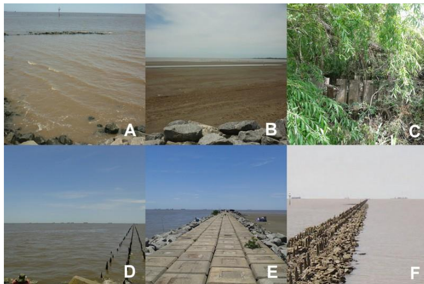
Figura 3: Mosaico A) Costa de erosión, B) costa de depositación, C) tablestacado y escollera preexistente, sumergida en pleamar; D) escollera actual; E) y F) relicto del tablestacado. Fuente: imágenes propias, 2015, excepto F) CORIPA, 2006.
