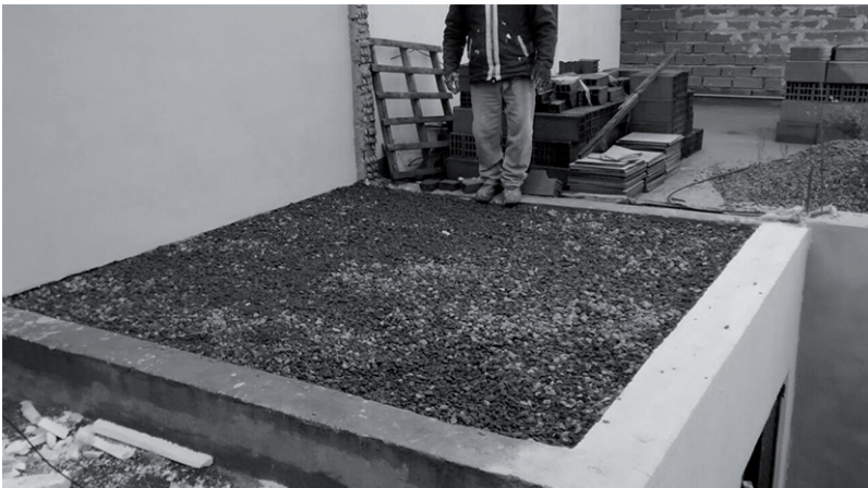
Terminación de losa aislada.
