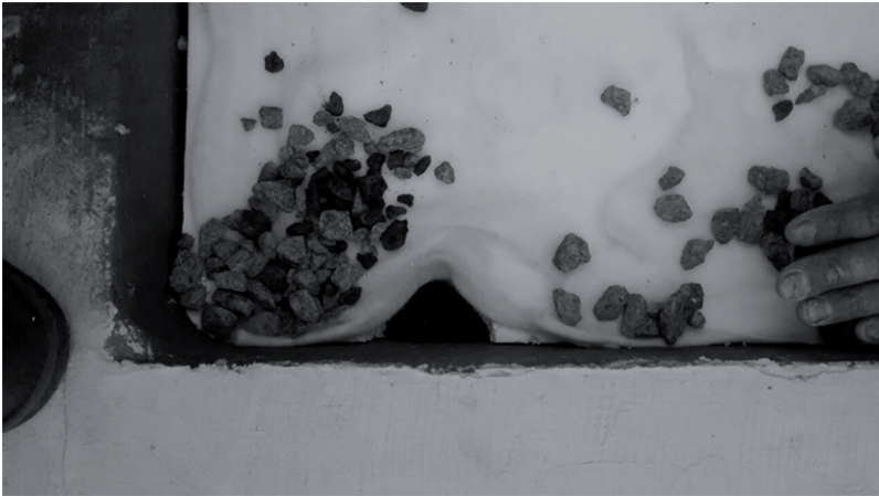
Detalle de protección de resumiadero de losa.
