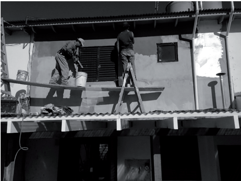
Aplicación de base coat .
