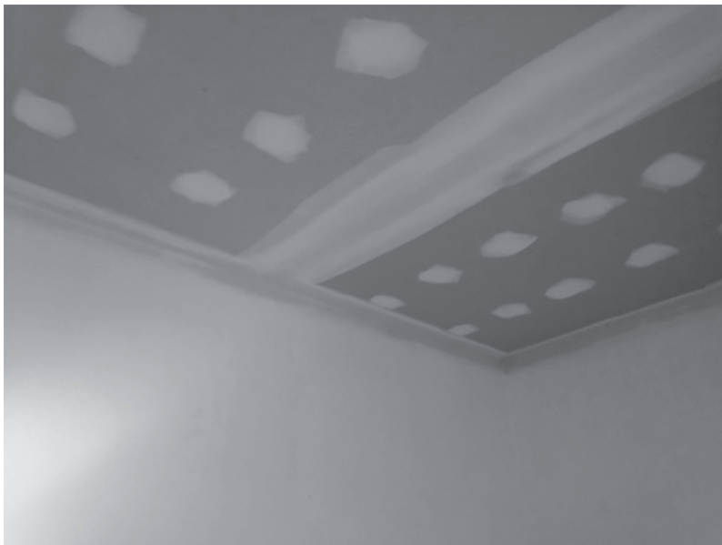
Colocación de placas con aislación superior.
