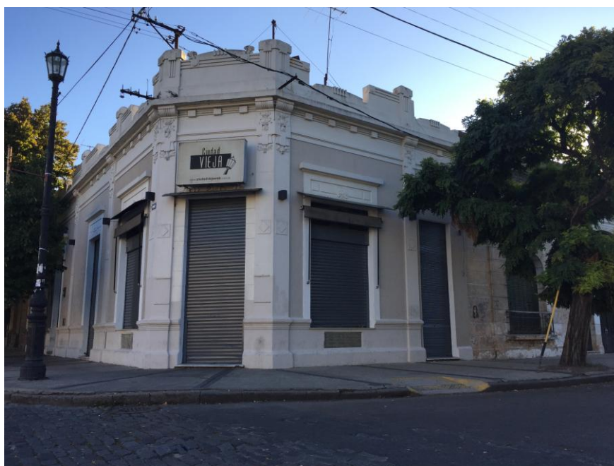
Bar instalado en antiguo local comercial
