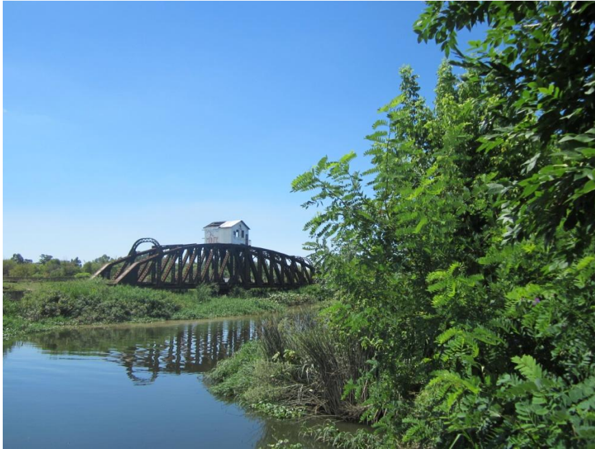
Puente giratorio sobre Canal Oeste
