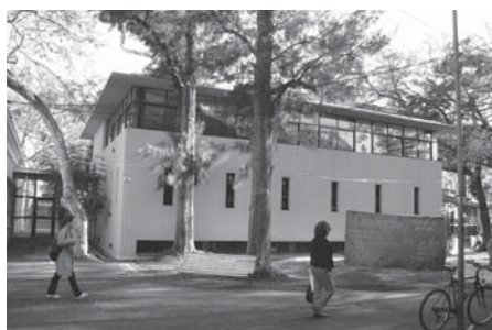
Figura 6. Vista sudeste del edificio.
