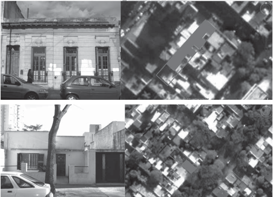
Figura 2 y 3. Relevamiento fotográfico y satelital de las tipologías analizadas. Arriba tipología Casa Chorizo . Abajo tipología Casa Cajón .
