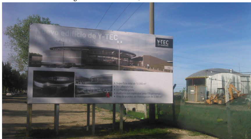
Figura 4. YTEC CONICET, inicios de la obra
