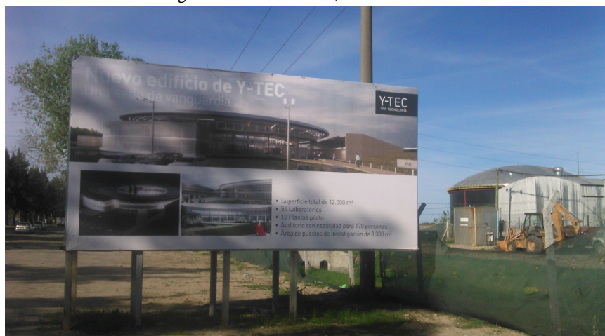
Figura 4. YTEC CONICET, inicios de la obra
