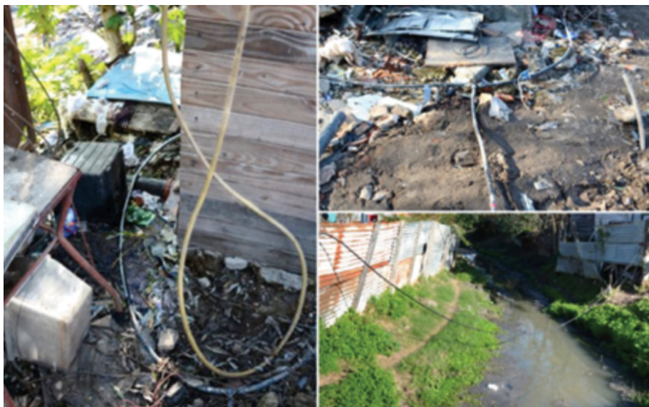
Figura 4. Conexiones de agua precarias a cielo abierto en la Cuenca Maldonado
