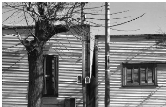
Figura 6: Separación entre viviendas
