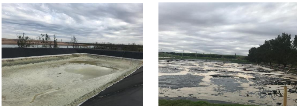
Fotos 15 y 16. Tratamiento de lixiviados, anaeróbica y aeróbica
